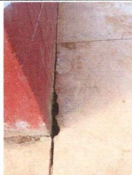
Foto 4: Se observa el deterioro del piso del establecimiento
