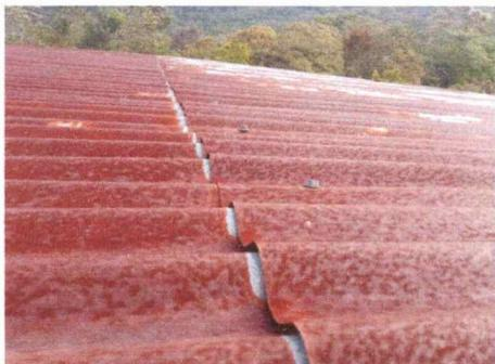
Foto1: Se observa que las laminas del techo de las aulas a intervenir, se ve en un deterioro total
